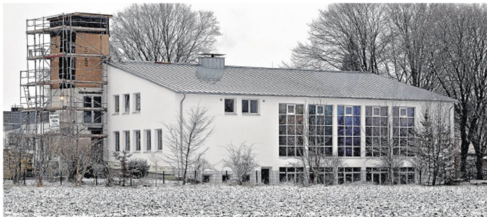
Der Turm der Synagoge ist noch eingerüstet, doch die Fenster im Gebetsaal sind bereits neu. Ihre Farben orientieren sich an den Farben der zwölf Stämme des Volkes Israel.
